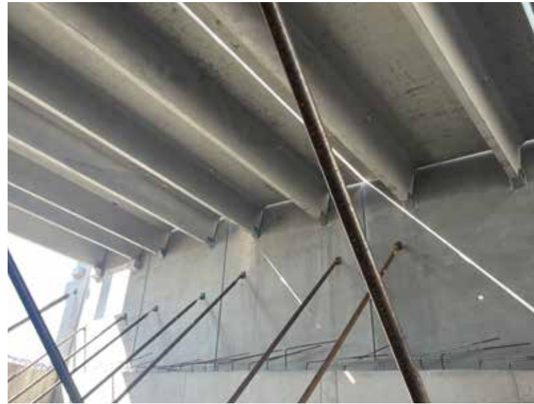
Iterative tools also improve coordination with precast fabricators. Photo : Strescon Limited. / Les outils itératifs aident aussi à améliorer la coordination avec les fabricants de béton préfabriqué. Photo: Strescon Limited.
